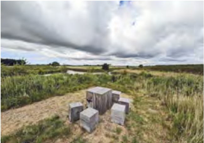
Rastplatz an der Lægan Pumpestation
