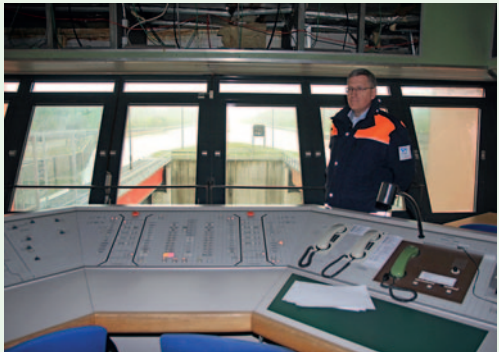
Im ehemaligen Steuerstand des Schiffshebewerks
